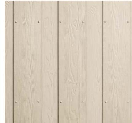
CEDRAL überzeugt auch in der vertikalen Verlegevariante als Boden-Deckel-Schalung. Der Name ist dabei Programm. Die stoßfesten Faserzementpaneele werden so an der Lattung angebracht, dass über zwei Boden-Paneele immer ein drittes Paneel als Deckel montiert wird. Im Gegensatz zur Stülpchalung sind die Verschraubungen bei diesem System sichtbar. Die farblich passenden Schrauben werden nach der Verlegung kaum wahrgenommen. Für die schöne Optik zählt eben jedes Detail.
